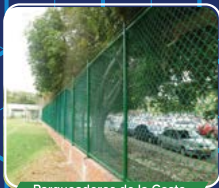
Parqueaderos de la Costa Obra parqueaderos de la Marina
