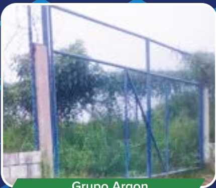
Grupo Argon Obra bodega Mamonal
