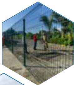
Cerramientos con postes metálicos
