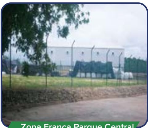
Zona Franca Parque Central Obras Panelmet y Estrumetales
